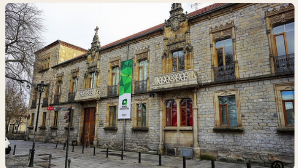
Palacio de Montehermoso. Siglo XVI (1524) Edificio de estilo gótico-renacentista.
